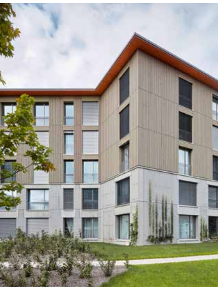
Die unteren Geschosse sind als Betonkonstruktion ausgeführt, die oberen als tragender Holzbau.
