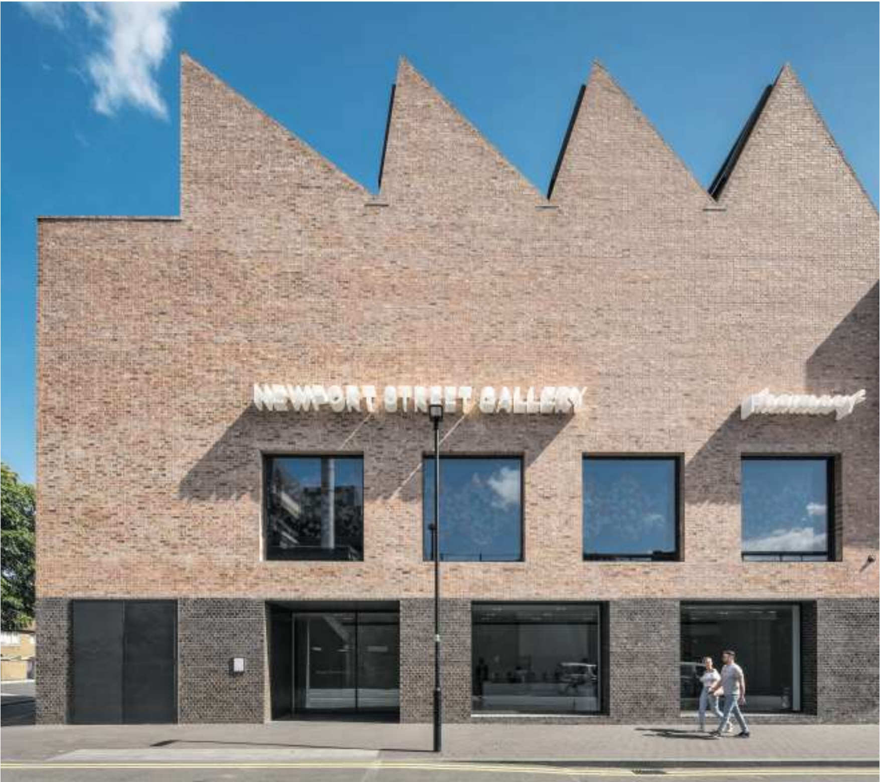
Beispielhafte Ziegelarchitektur, die über poetische Qualität verfügt: die Newport Street Gallery in Vauxhall (2016) von Caruso St John.
