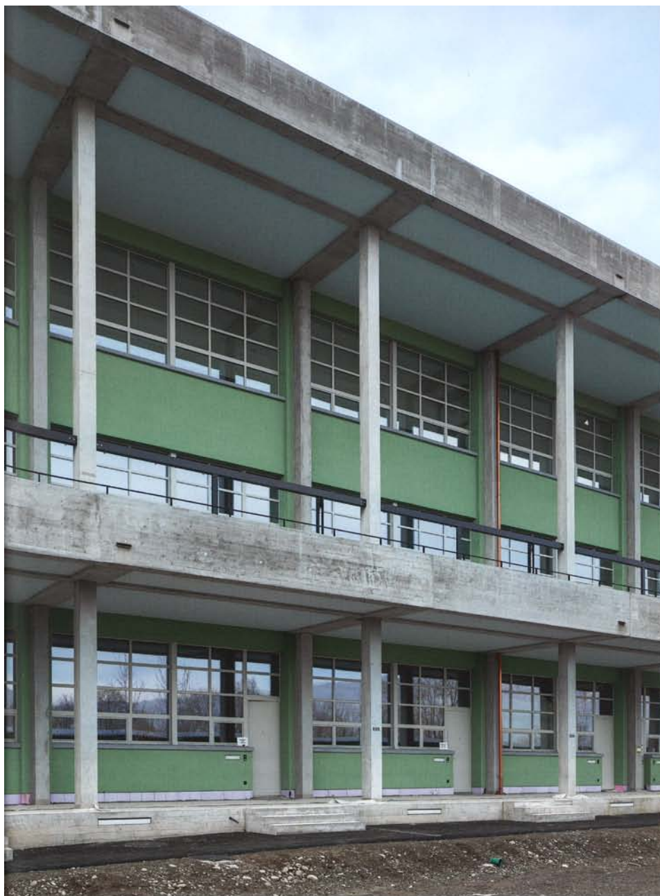
Raumartige Erschliessungsschicht als Identitätsträger: Laubengänge an der Nordfassade
