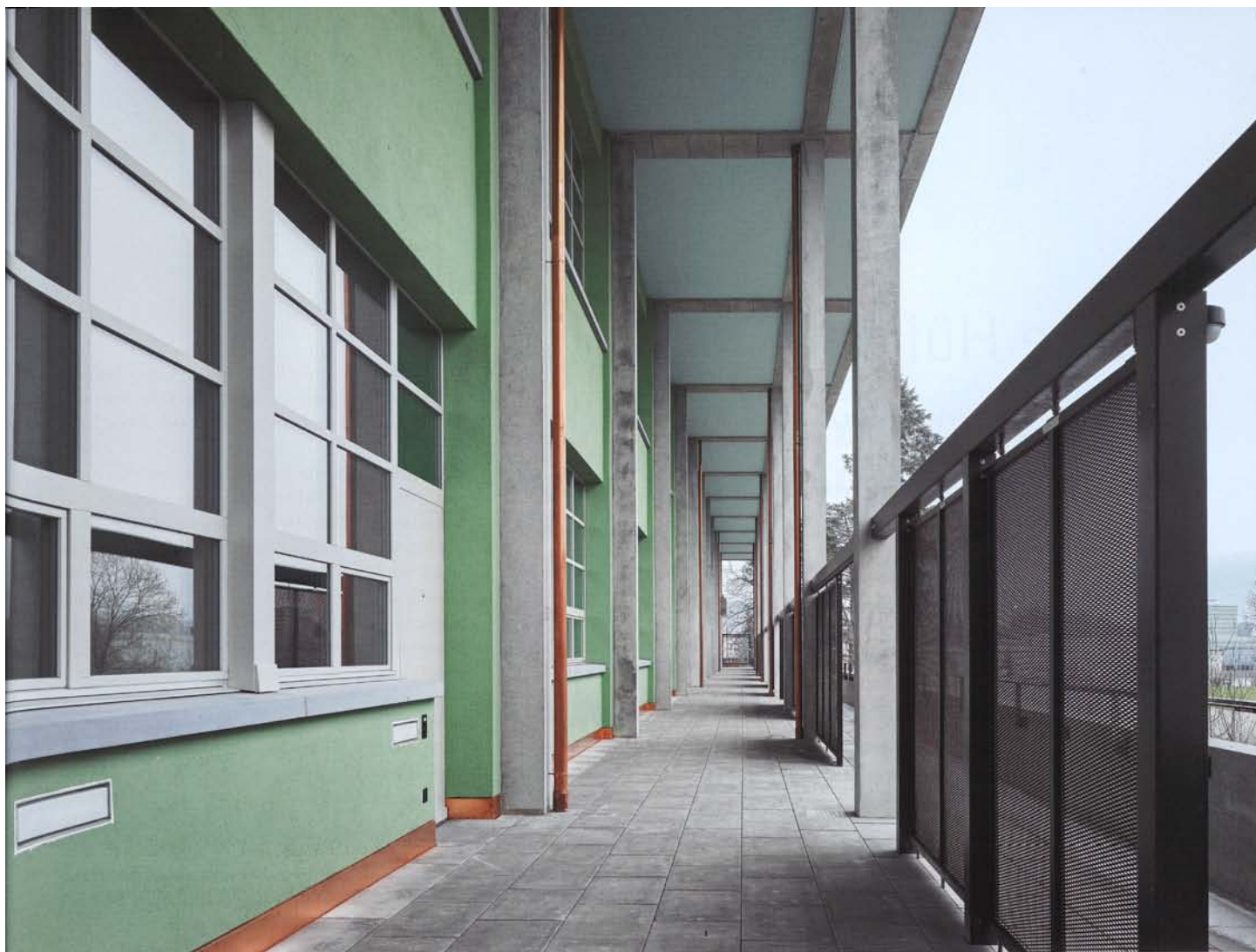
Laubengang im 1. OG mit Sichtschutz aus Streckmetall
