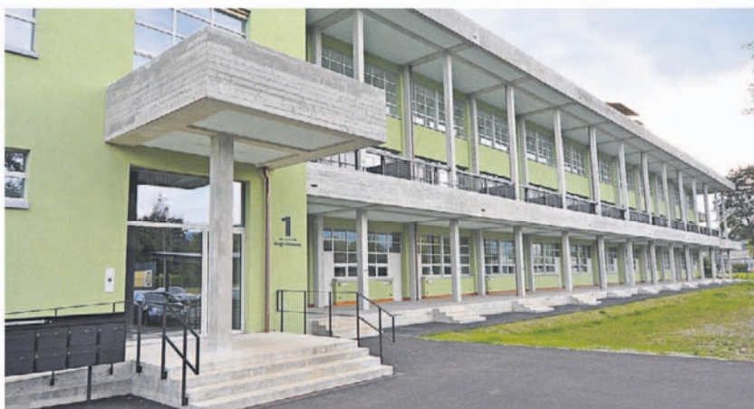
Die ehemalige Schuhfabrik Hugi – hier die Nordansicht mit den laubenartigen Erschliessungen – und ihr Investor Markus Ehrat erhielten den diesjährigen Heimatschutzpreis des Kantons Solothurn, weil es Ehrat gelungen war «ein tragfähiges Sanierungs- und Nutzungskonzept zu entwickeln und umzusetzen».
