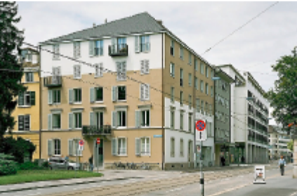
Wohn- und Geschäftshaus Selnau Der Weiterbau der bereits mehrfach veränderten Häuser ist nicht kaschiert, sondern mit sichtbaren Fugen und Materialwechseln im Innern und Äussern ablesbar.
