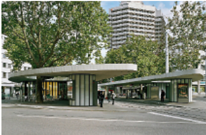
Tramhaltestelle Limmatplatz Das schwungvolle Oval des Dachs zeichnet die Begegnungen von Fussgängern, Trams, Auto- und Veloverkehr im Kreisverkehr um den Limmatplatz dynamisch nach.
