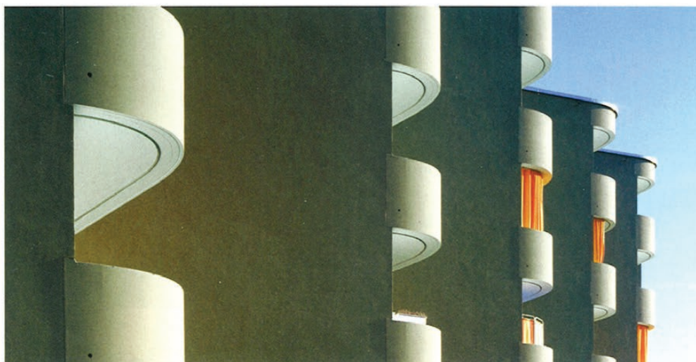
← 09 Die neuen, erweiterten Balkone sind nun eine veritable Vergrößerung des Wohnraums.
