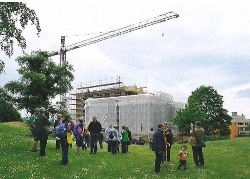
Visite du chantier par les futurs habitants.
