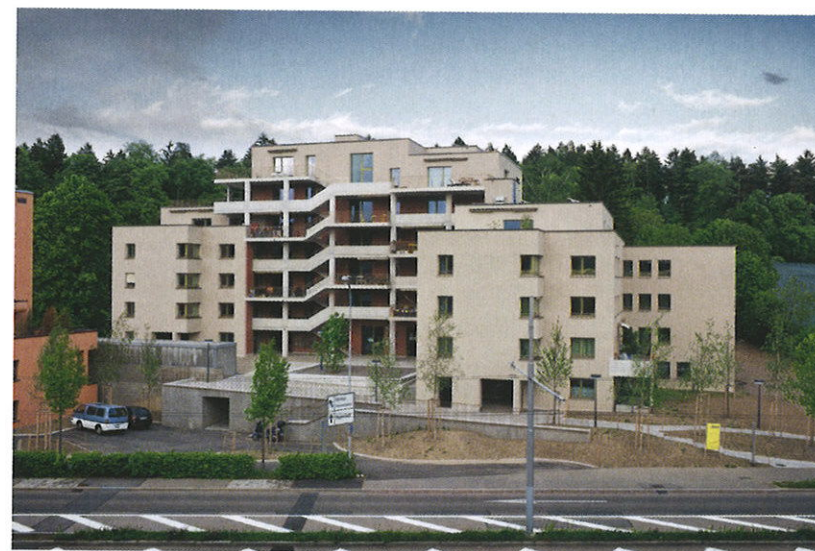
Vue d'ensemble du bâtiment Kraftwerk 2.
