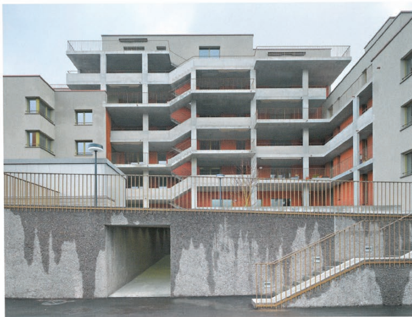
42 | Architektur | Kraft Werk 2, Zürich
