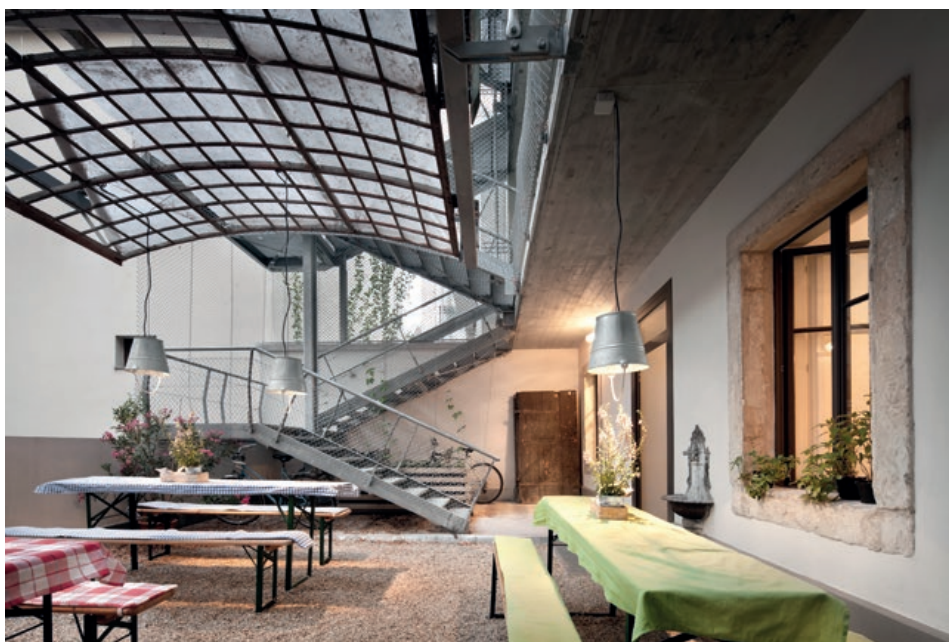
Abb. 18: Beim Umbau des Projekts 04_VinziRast-mittendrin wurden möglichst viele Bauteile und Materialien erhalten oder an Ort und Stelle wiederverwendet, wie zum Beispiel das hier abgebildete Dach des Lichthofes. © Kurt Kuball
