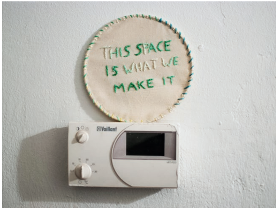
Abb. 112: Das Haus wurde kooperativ konzipiert und umgebaut. © GSG
