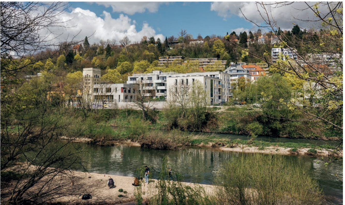
Abb. 47: Blick über den Neckar auf den Gebäudekomplex © Verena Müller
