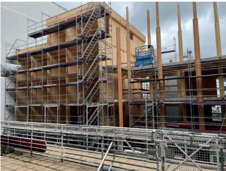
Abb. 59: Baustelle des Erweiterungsbaus im Hinterhof mit Clusterwohnungen (2024) © Schwulenberatung Berlin
