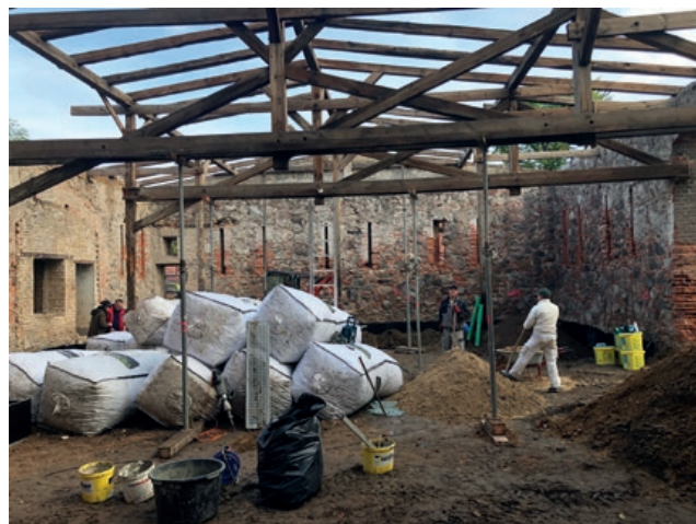
Abb. 84: Entkernung der Kleinen Scheune © Hütten und Paläste
