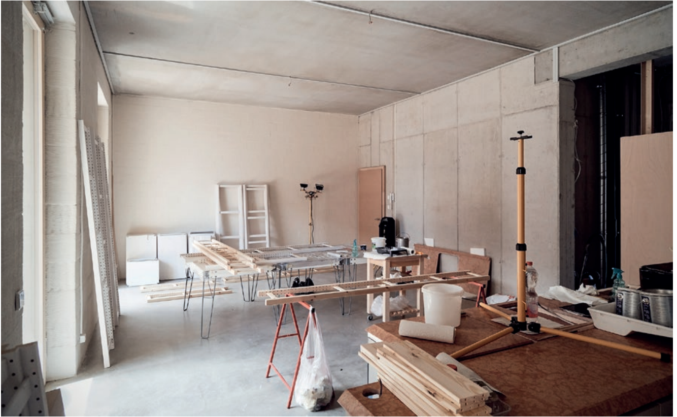
Abb. 100: Selbstausbau in der Praxis © Roland Schmid
