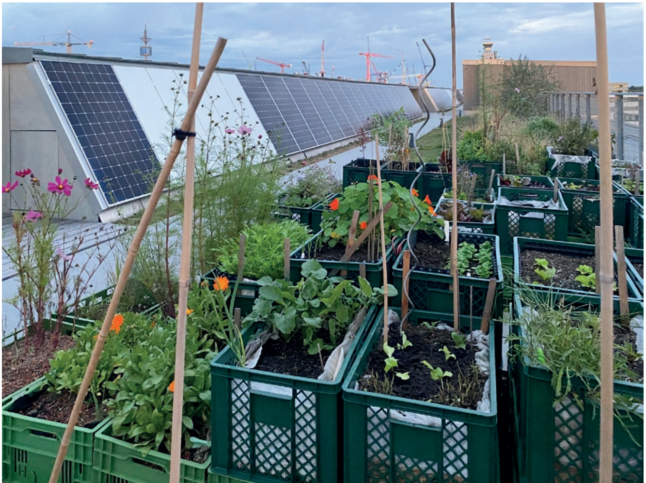
Abb. 165: Dachgarten mit Photovoltaikanlage © Katharina Wildemann
