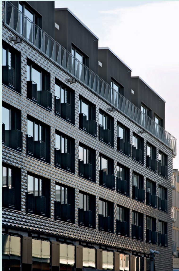
Abb. 31: Keramische Gebäudehülle des IBeB © Andrew Alberts
